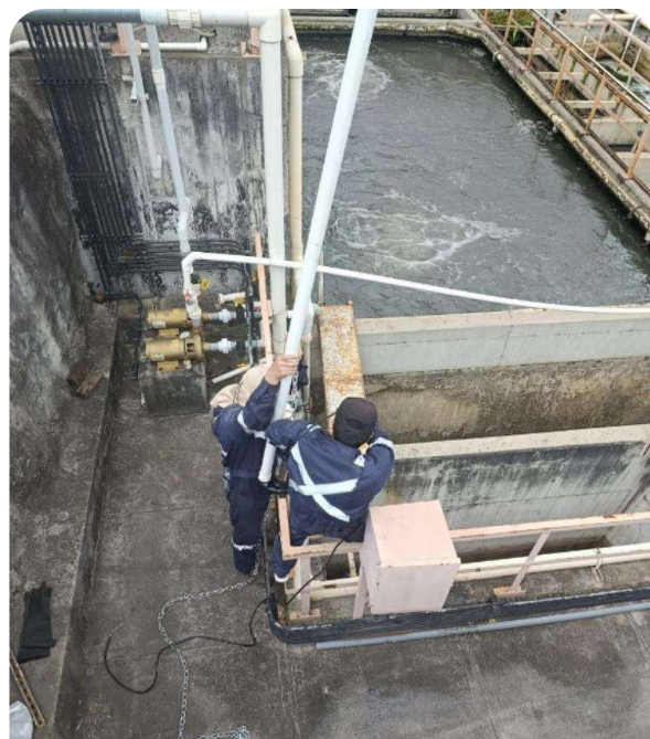
Instalación de Bombas y Aireadores en Planta de Tratamiento de Aguas Residuales
