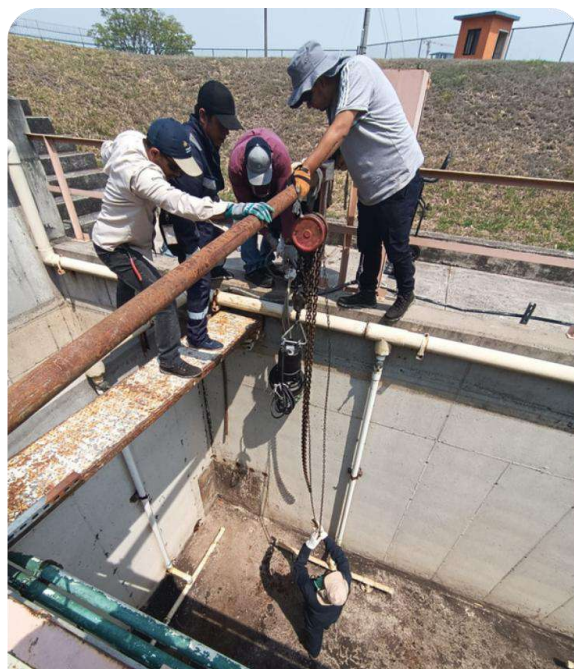
Instalación de Bombas y Aireadores en Planta de Tratamiento de Aguas Residuales
