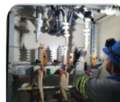
Mantenimiento y Reparación de Generador
